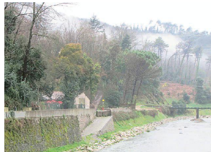
L'area prima dell'intervento
